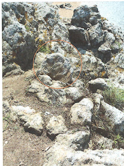
Retrait de la végétation pour la mise en valeur de la tête, côté plage du Val. Vue avant et après intervention.
