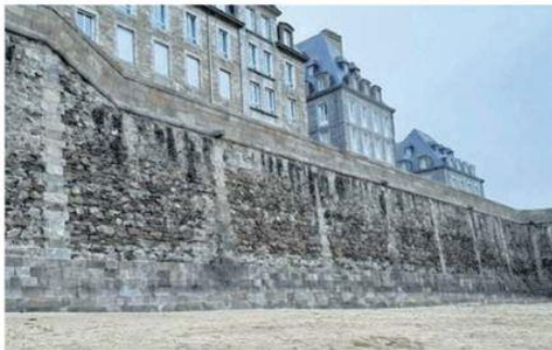
Des travaux vont être effectués sur certaines parties des remparts, notamment ceux qui surplombent la plage du môle. (Ville de Saint-Malo)
